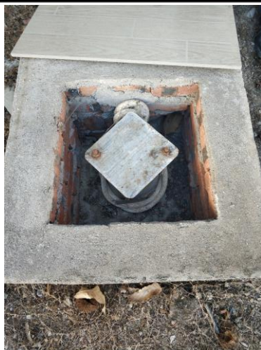
厂区地下水井
