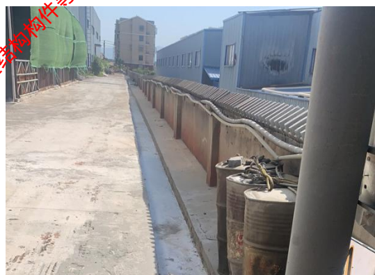
生产废水导流渠
