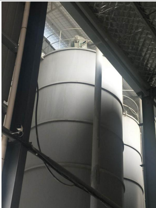
水泥筒仓仓顶排气口
